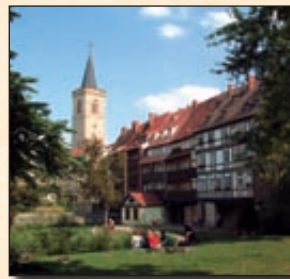
Krämerbrücke in Erfurt
